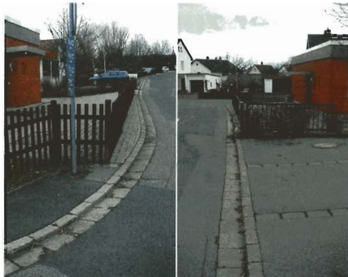
Schulweg Untersiemau: Der unterbrochene Gehsteig zur Schule (Foto li.) wurde durchgängig neu angelegt (Foto r.). Hierfür hat die Gemeinde das erforderliche Stück Fläche erworben. Die Sicherheit der Schüler auf dem Weg zur Schule ist dann weitaus ungefährlicher geworden.
